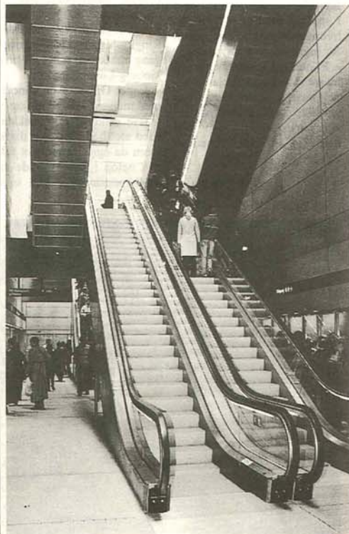
Det imponerende byggeri under og over jorden, stationerne, de er utroligt smukke, lyse og venlige med mange rulletrapper, der findes dog elevatorer ved samtlige stationer. Da man ikke befinder sig længe på en Metro station findes der ikke toiletter og kiosker nogen steder. Billetter købes i automater.
