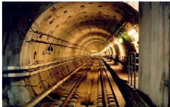
Tunnelen er på det dybeste sted, ved Kongens Nytorv, treogtredve meter under jordoverfladen.
